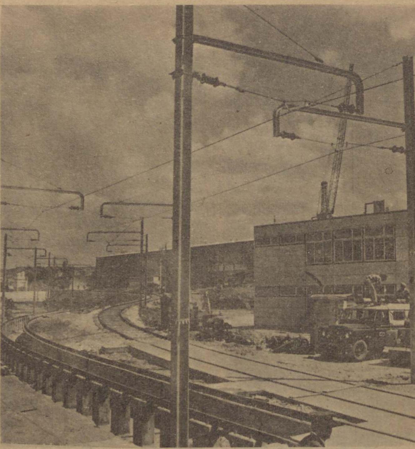
Concluiu-se no passado mês de Junho a electrificação do Ramal Particular da Sorefame, que equela empresa encomendou à C. P.. A electrificação abrange duas linhas de ensaio para material motor eléctrico, além do ramal que as liga à linha de Sintra.
