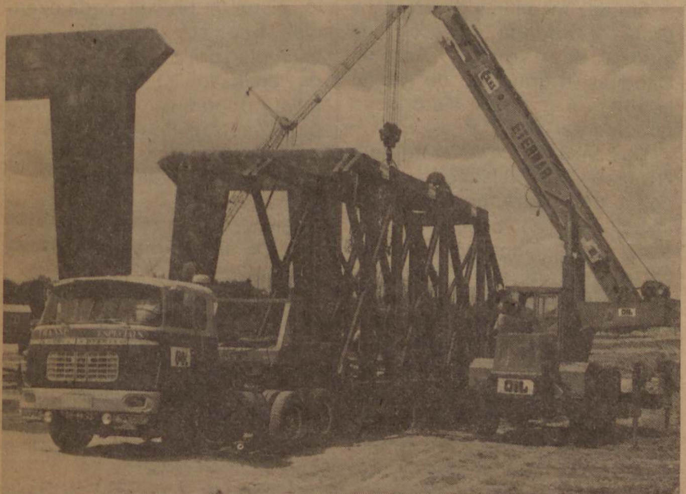
Transporte e montagem do cimbrio do tabuleiro
