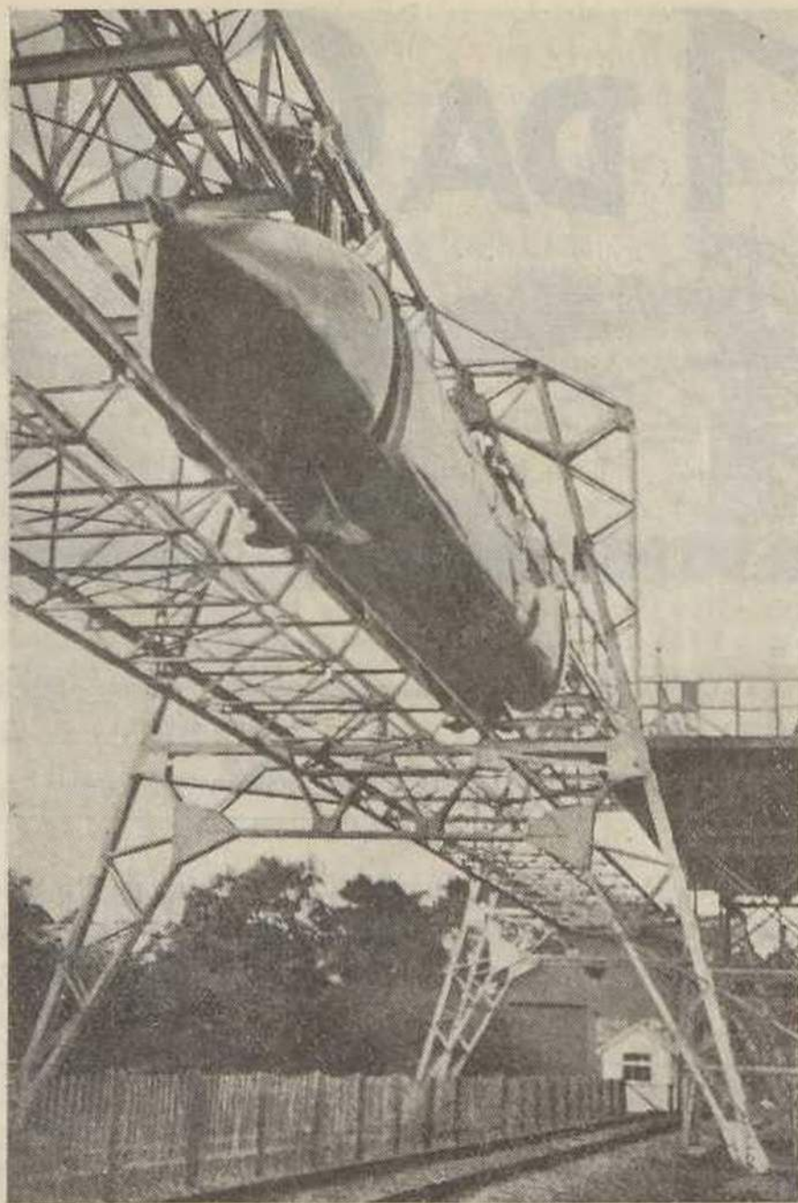
Os cavaletes metálicos que sustentam os carris, sobre os quais correm as rodas dos carros ( bogies ) do carril-plano
