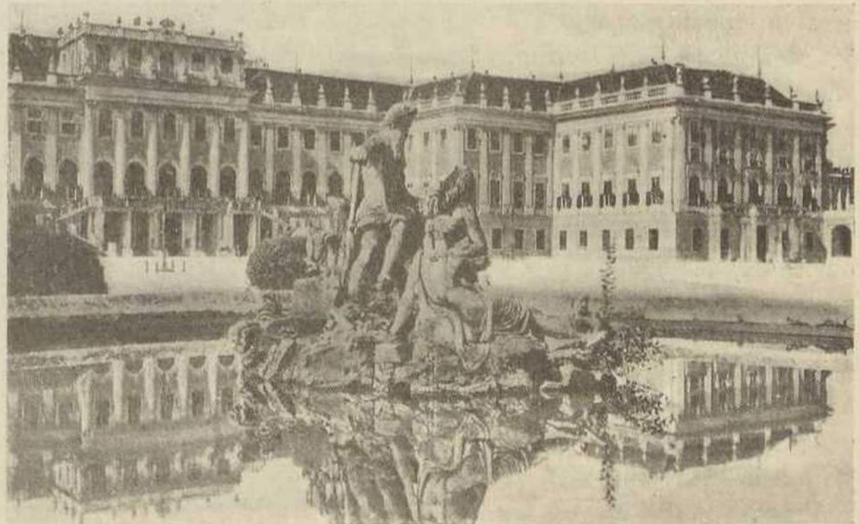
O Palácio de Schönbrunn. Jardins admiráveis, mas esta construção, tôda de «massa» a fingir pedra e caiada a oca amarela, está longe de ter a imponência que a gravura faz supôr
