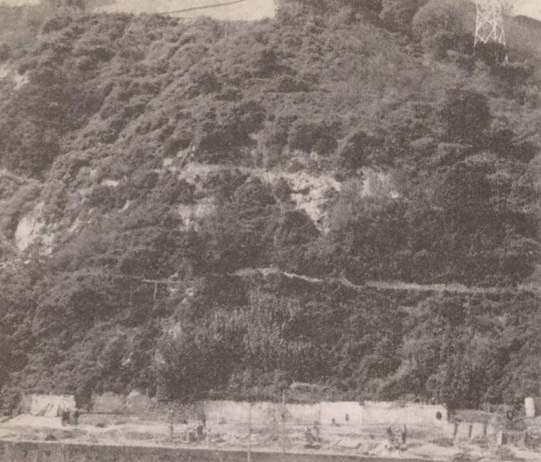
A encosta de maior pendor sobre a linha férrea : Portas do Sol. As obras estão decorrendo de forma a conservar-se a histórica muralha, mantendo-se a configuração da altaneira escarpa. Foram construídos dois muros de suporte a dois níveis diferentes (cotas 14 e 31) para aguentar todo o grandioso maciço
