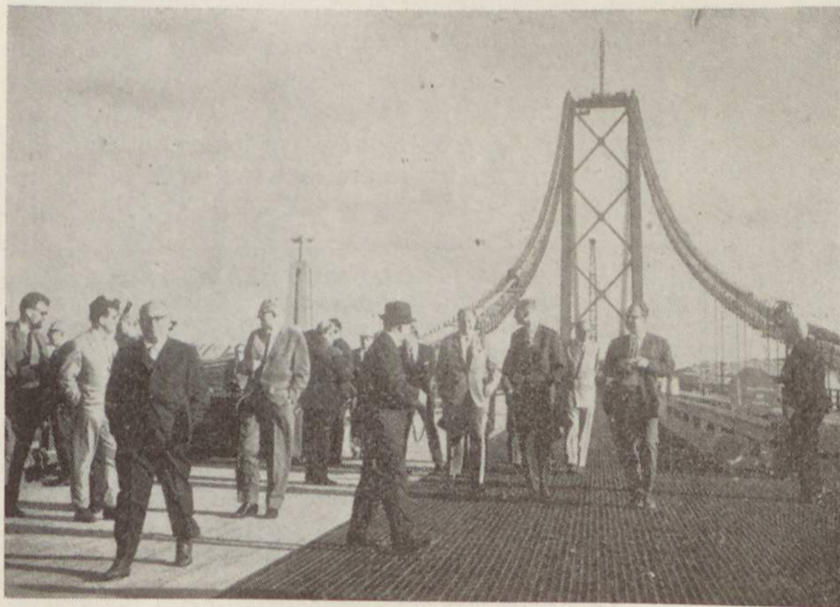
Os delegados visitaram as obras da grandiosa ponte sobre o Tejo
