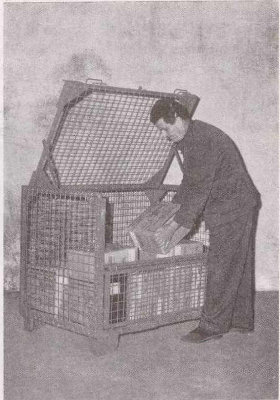
O neófito dos utensílios de manutenção da Companhia: a caixa-estrado fechada. Dotada de paredes de rede metálica de 5 mm, com malha de 50 mm, ela permite inspeccionar do exterior o seu conteúdo, oferecendo simultaneamente excelentes condições de segurança: pode ser fechada com cadeado e selada. Com uma capacidade útil de 0,78 m 3 e uma carga útil de cerca de 900 kg, estas caixas-estrados constituem o meio ideal de carregamento de pequenos volumes, sem embalagem ou com embalagem reduzida
