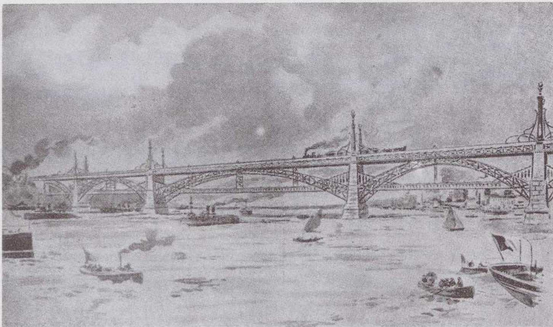
Visão da ponte metálica Miguel Pais, primeira tentativa concreta de ligação contínua entre Lisboa e a Outra Banda, estudada em 1876. Possuía 4300 metros de extensão e localizava-se entre o Montijo e Xabregas. Destinava-se simultaneamente ao trânsito ferroviário e rodoviário
