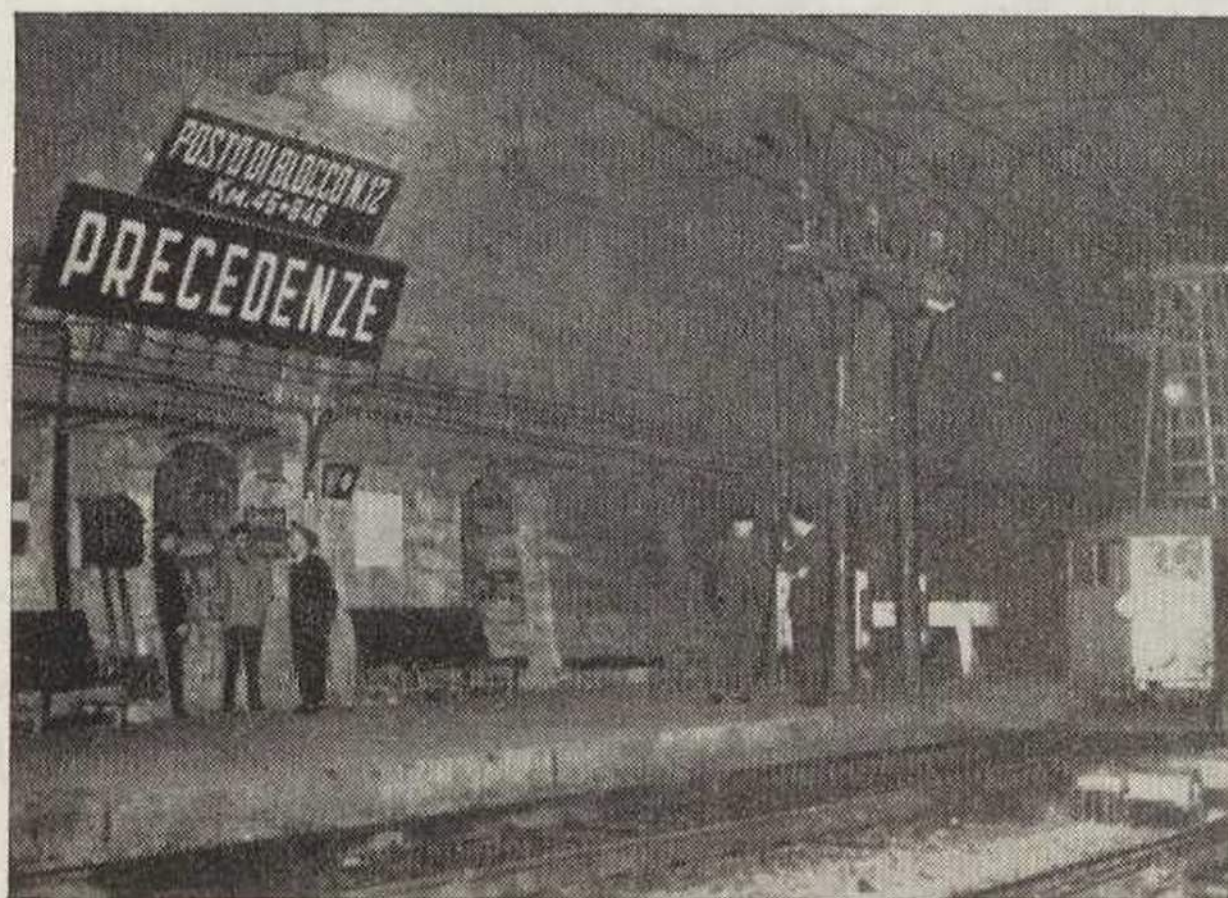
Curiosa vista de uma estação no interior de um dos grandes túneis italianos (dos Apeninos). Esta estação não tem qualquer função comercial, destinando-se apenas a assegurar a circulação de comboios (posto de bloco e de cruzamentos)
