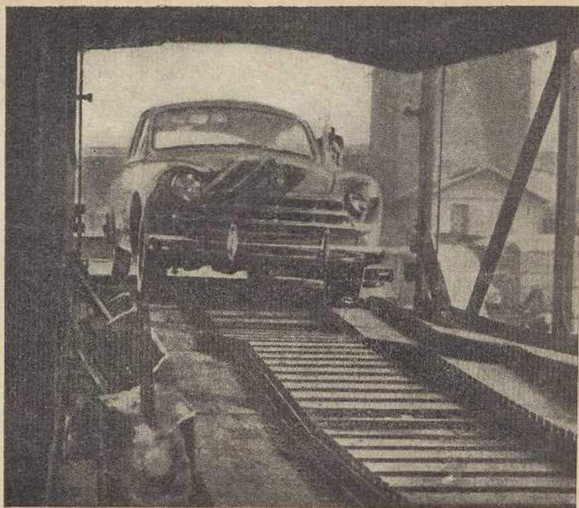
Um «Renault», saindo do cais de embarque para ser instalado num vagão de dois pisos.
