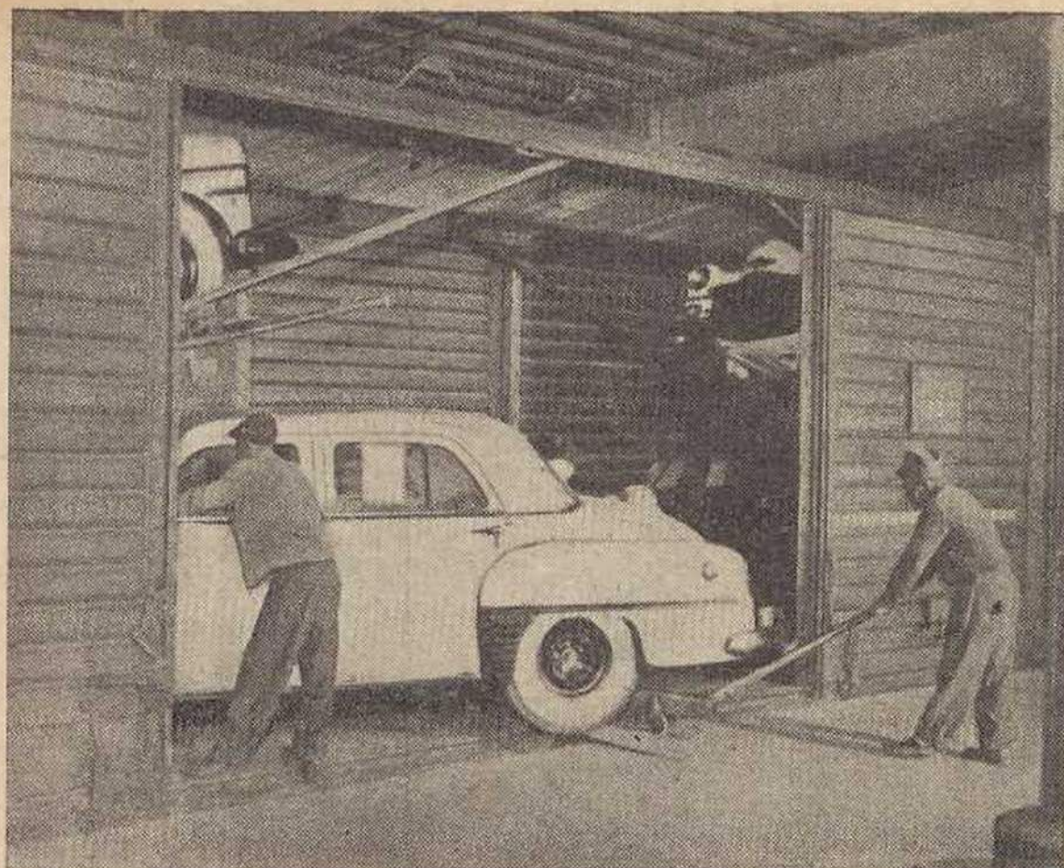
Um vagão especial, coberto, do «New York Central», que pode transportar, ao mesmo tempo, quatro automóveis
