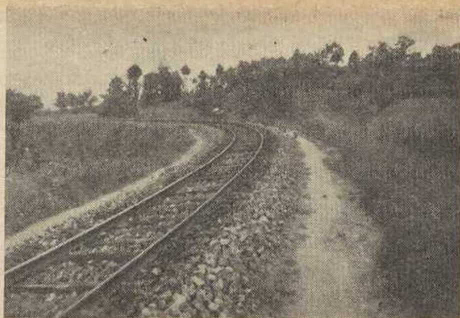
Dois assentadores corrigindo defeitos na curva de rail 95 na linha do Vale do Côrço
