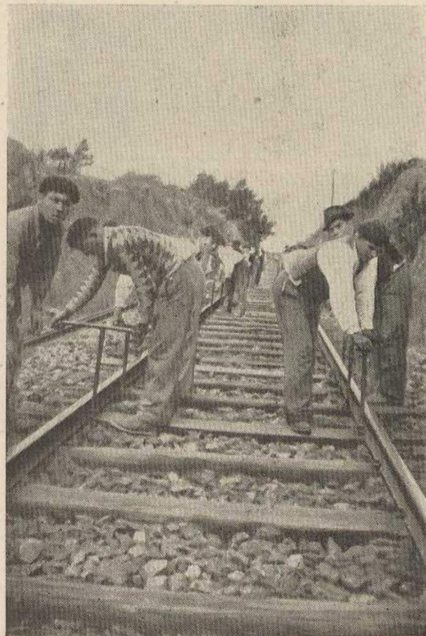
Preparação de um corte da linha
