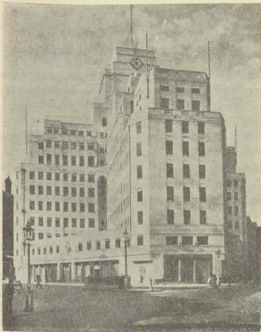
Fig. 1 — Edifício dos novos escritórios centrais do Metropolitano de Londres
