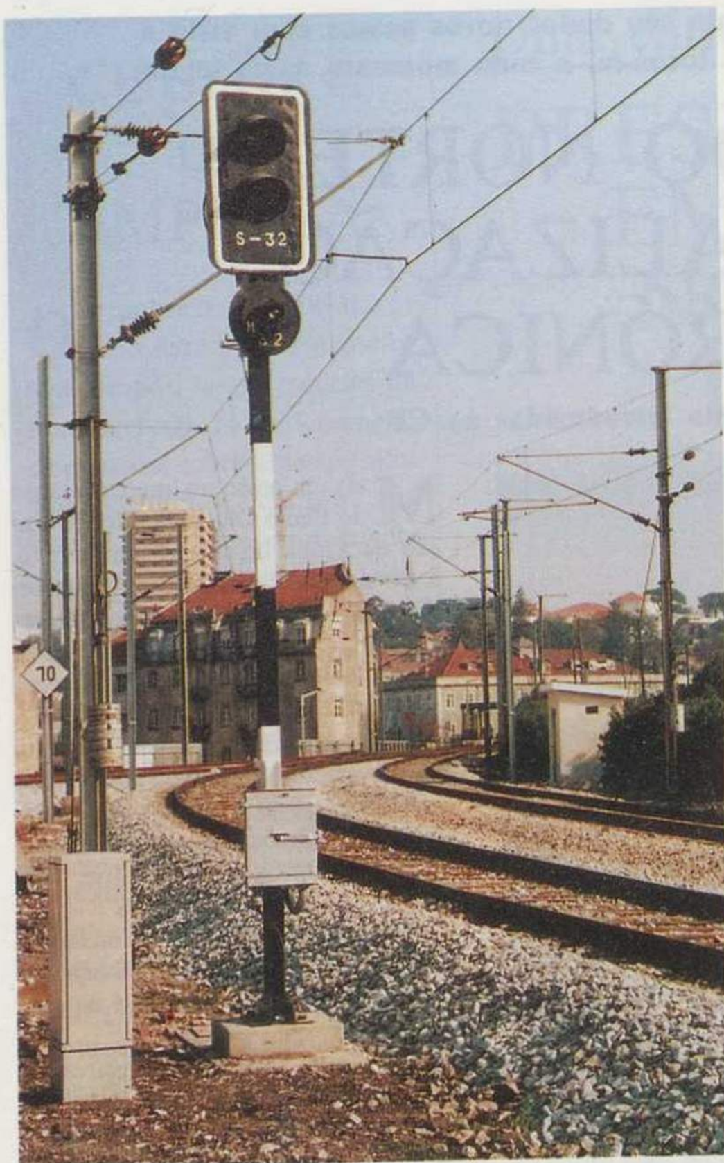
Travessas novas, monobloco e em betão, desnivelamentos permitindo (em Campolide) o lançamento da via de Cintura, novo sistema de sinalização e controlo, completam os trabalhos de renovação do Nó Ferroviário
