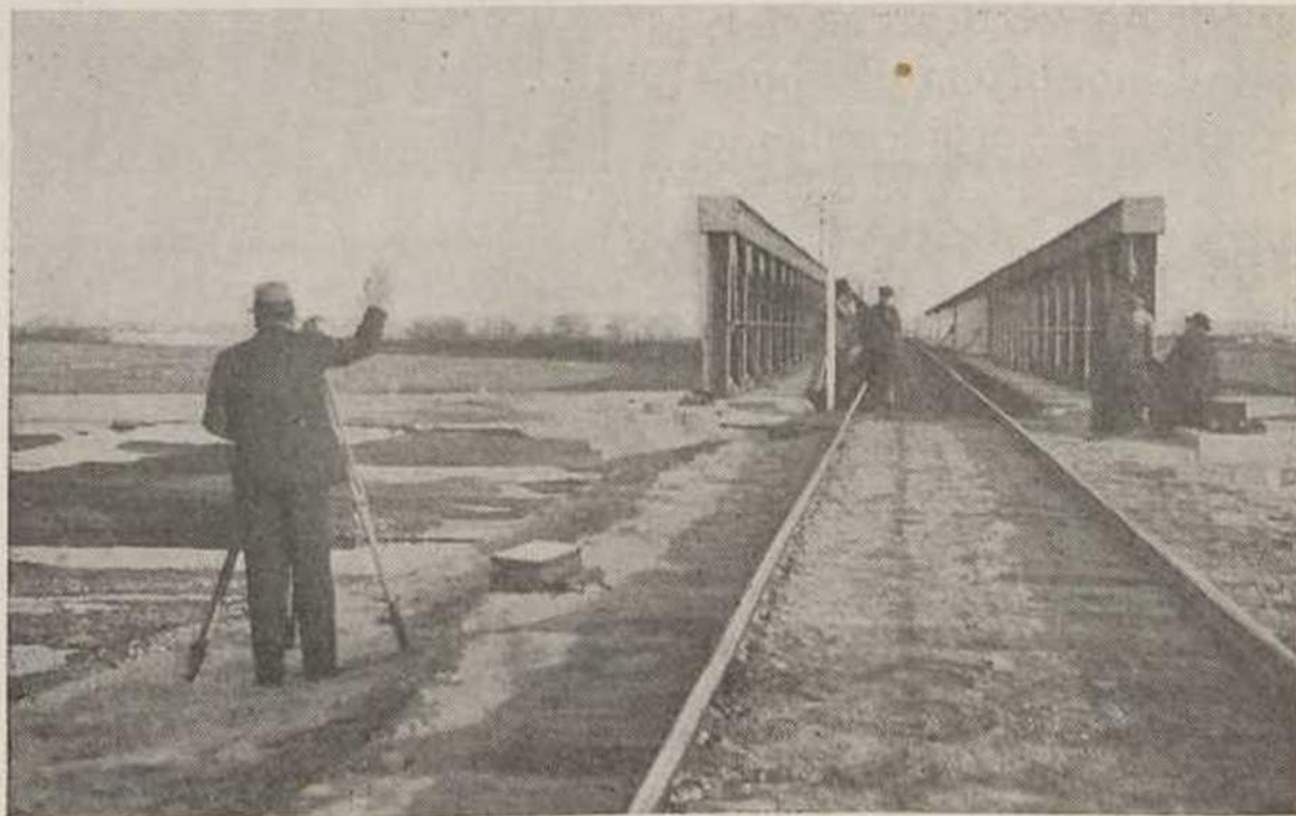
O Secretário da Comissão de Pontes procede à verificação do nivelamento do novo tramo antes e depois dos ensaios.
