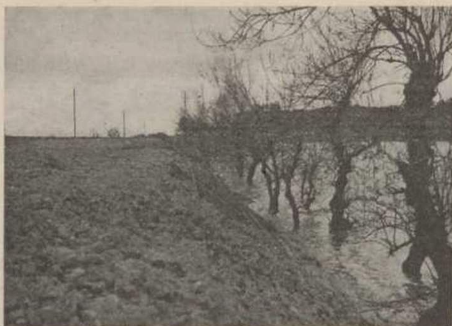
O balastro e as vias da linha do Leste, ao quilómetro 57 foram arrastadas para o lado do Cartaxo.
