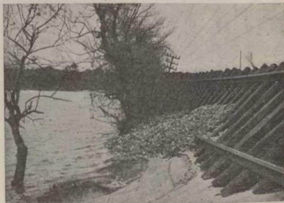
Os salgueiros da base do atêrro da linha de Leste, ao norte da estação de Setil, lado do poente, resistiram ao ímpeto das águas e sustentaram ambas as vias.
