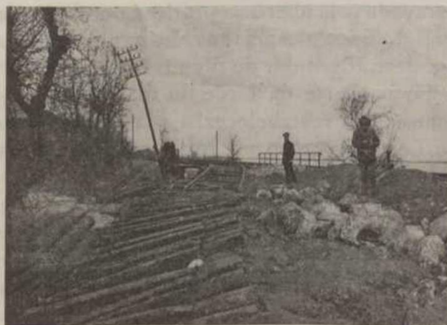
Se não fôsse a firmeza do pontão ao km. 57,409, maior teria sido a extensão de linha arrastada.
