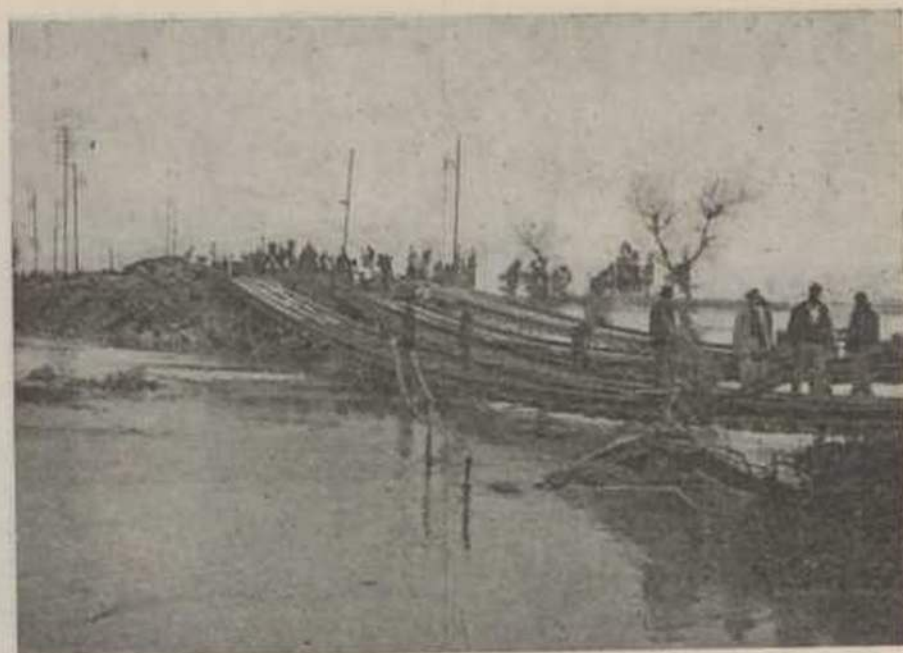
O estado em que se apresentavam as linhas de Leste e Vendas Novas à saída do lado norte da estação de Setil, quatro dias após a cheia, quando as águas baixaram.
