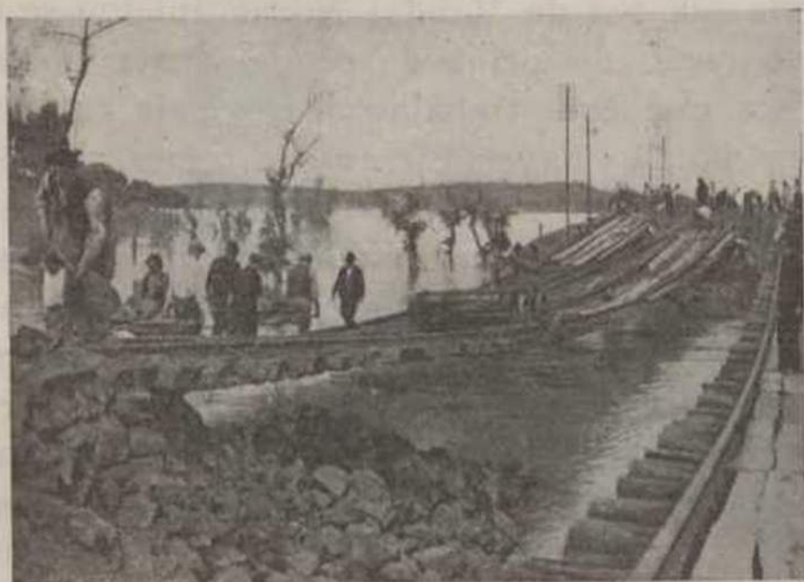
Reparação do rombo do atêrro da linha de Leste, com basalto de Campolide.
