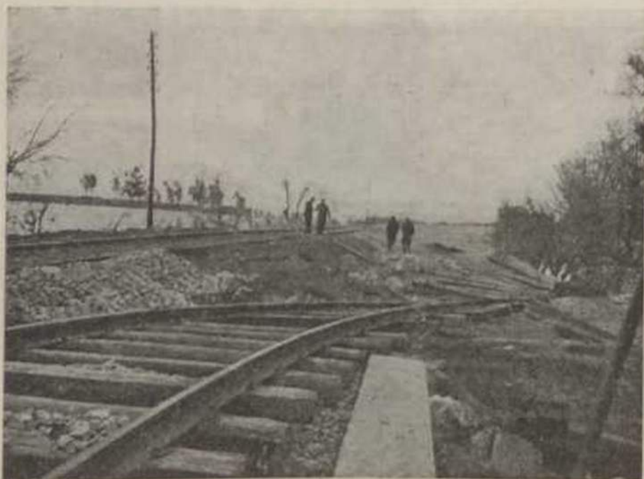
De cima do encontro lado sul do pontão ao km. 57,409 de Leste a linha descendente tinha já sido levada à sua posição mas a ascendente vê-se ainda como as águas a puzeram.
