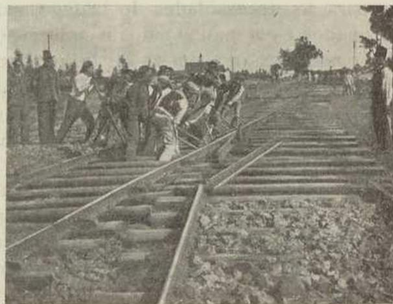
Fig. 4 — Frase de ligação provisória da linha do Sado com a do Sul
