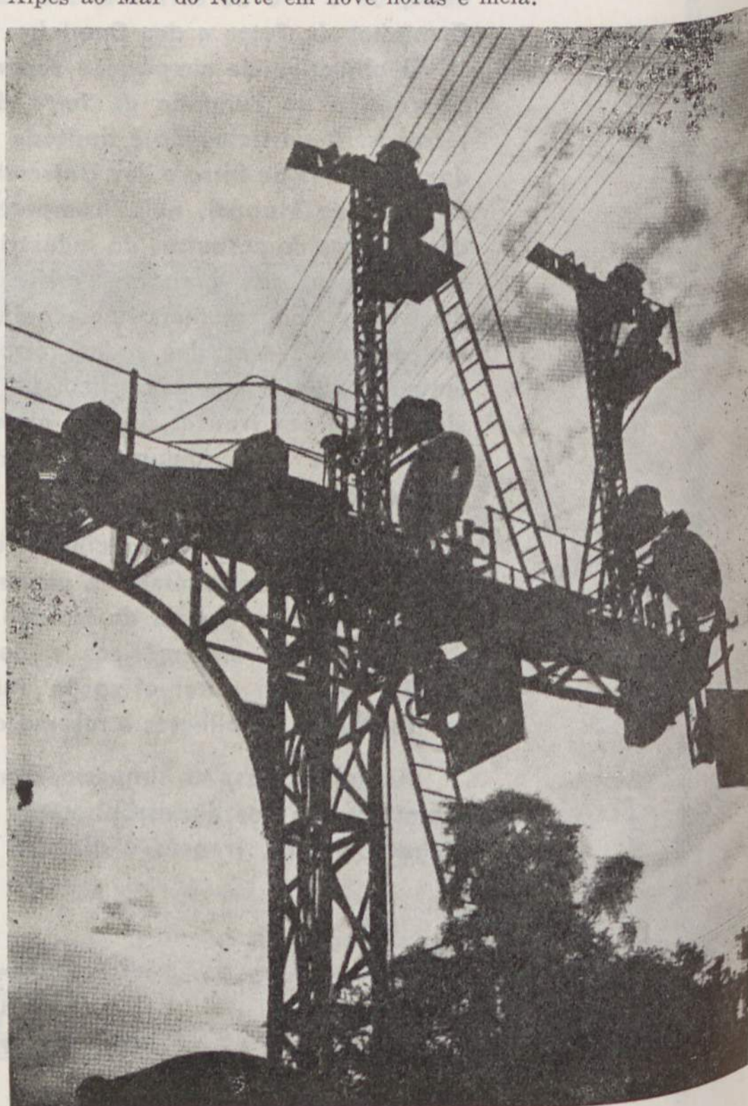
Poste de sinalização nos Caminhos de Ferro Franceses
