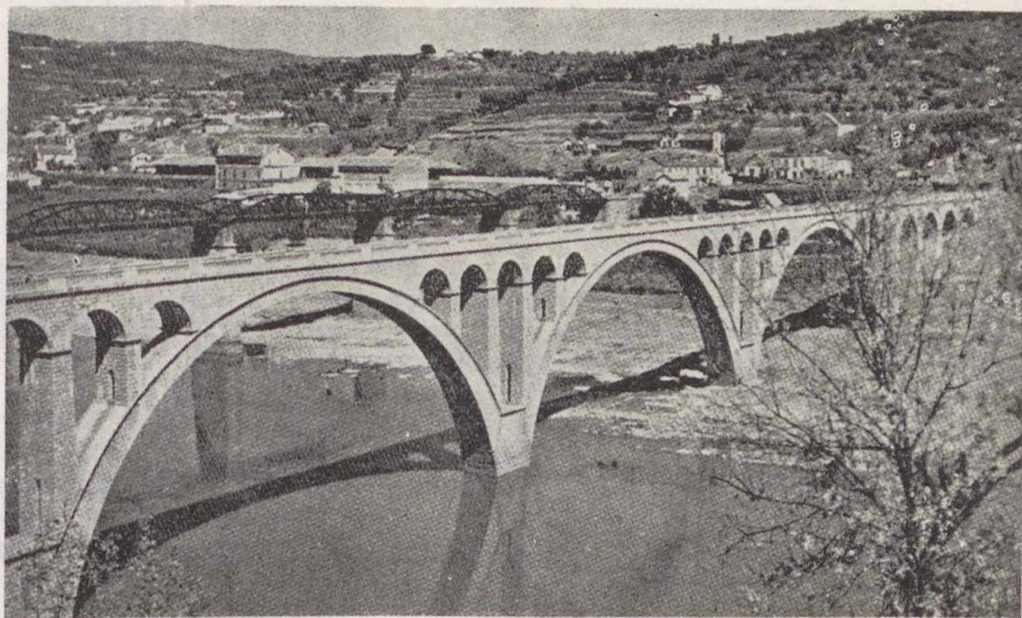
Ponte sobre o Douro na Régua
