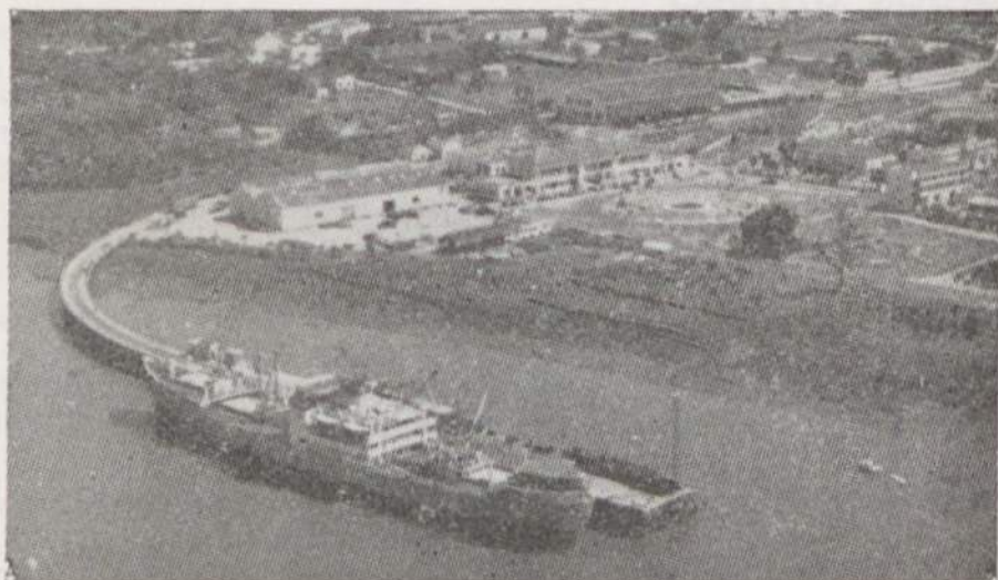
Aspecto parcial do porto da Beira
