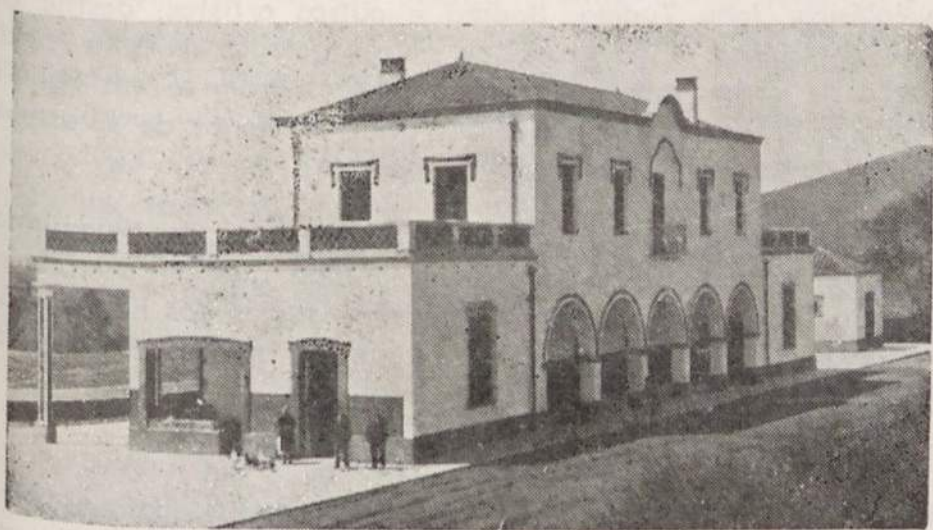
Estação de Jerez (2.º troço)
