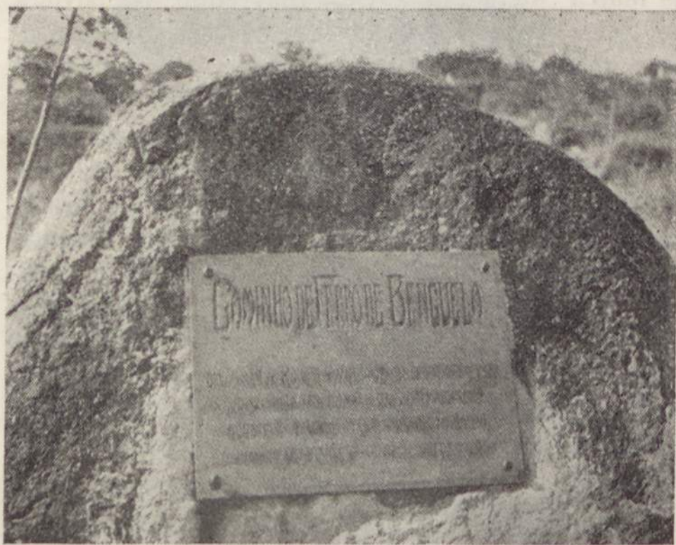
Esta gravura reproduz a placa que, próximo de Dilolo, na extremidade oriental do Caminho de Ferro de Benguela, comemora a construção e a abertura desta importante linha
