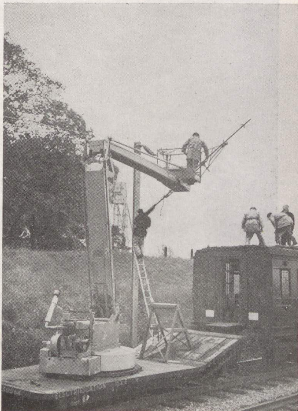
Trabalhos de electrificação de via. Em via simples ou dupla, o equipamento é geralmente suportado por pontes de uma via. Esta fotografia mostra a erecção da ponte com a utilização de uma plataforma hidráulica
