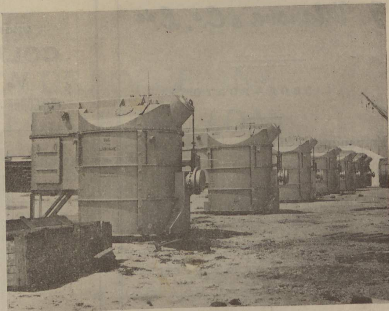
Auto-transformadores de 220/150 kv. destinados à subestação de PEREIROs da C. N. E. depois do desembarque no porto de Lisboa
