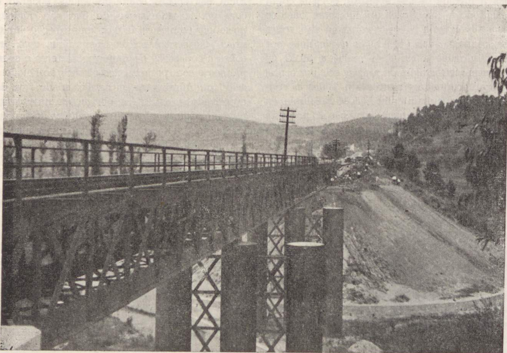
Aspecto da Ponte de Seica
