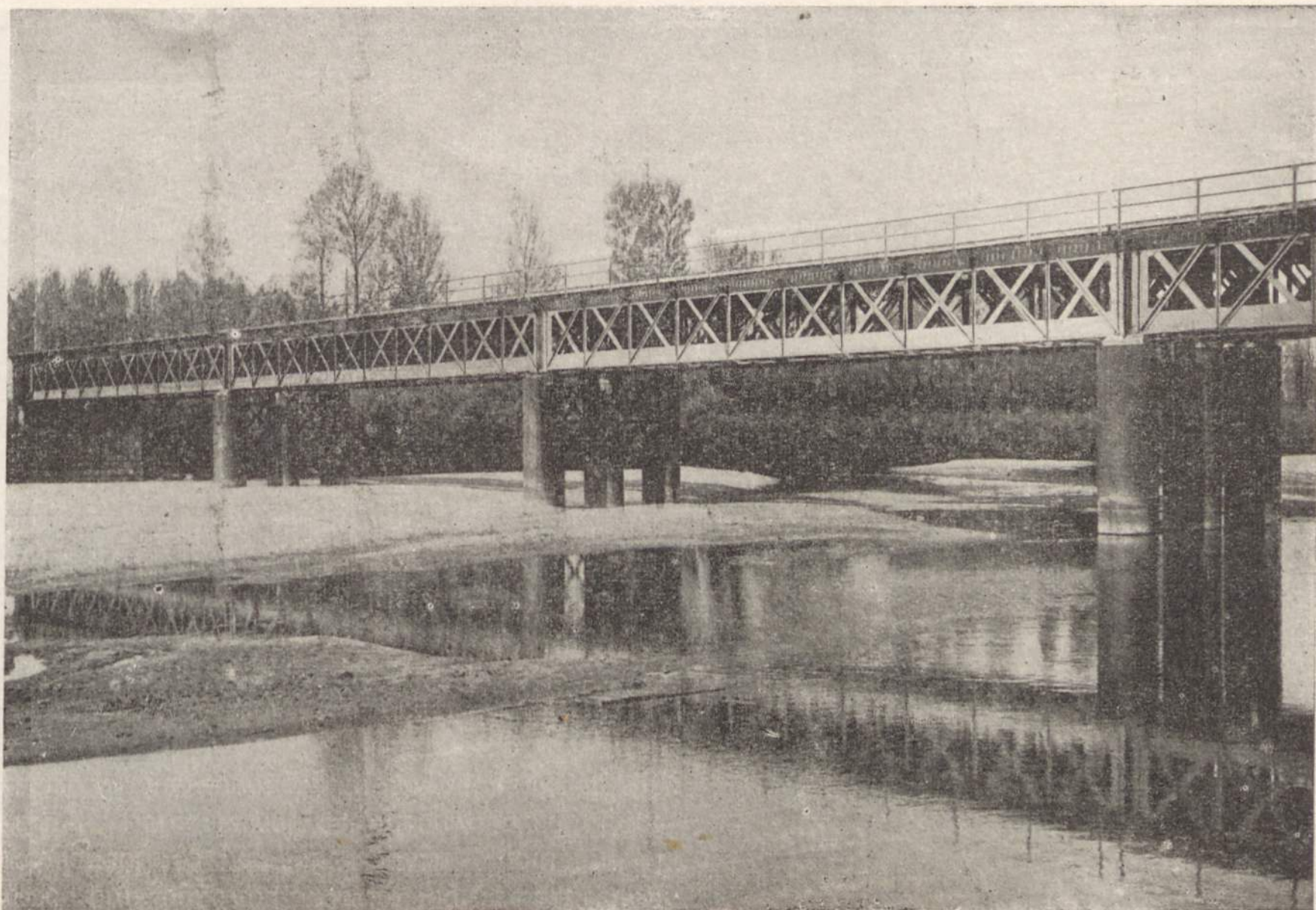
Ponte sobre o Mondego — (Foto do Eng.º F. Gonçalves)
