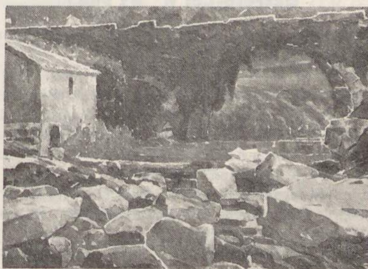
Velha ponte sobre o Rio Ul
