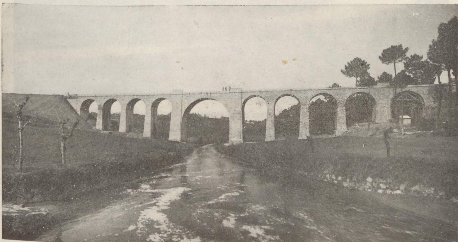
SEIA — Ponte sobre o rio
