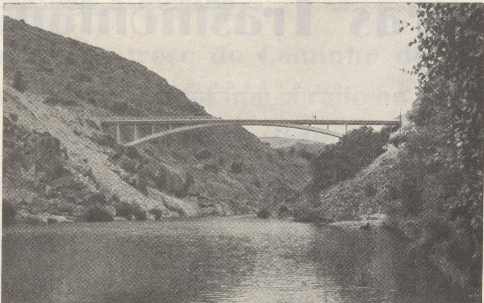
Ponte de Abreiro, sobre o Tua
