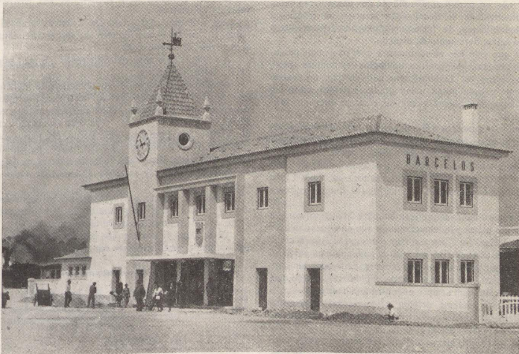
BARCELOS — A entrada da nova estação
