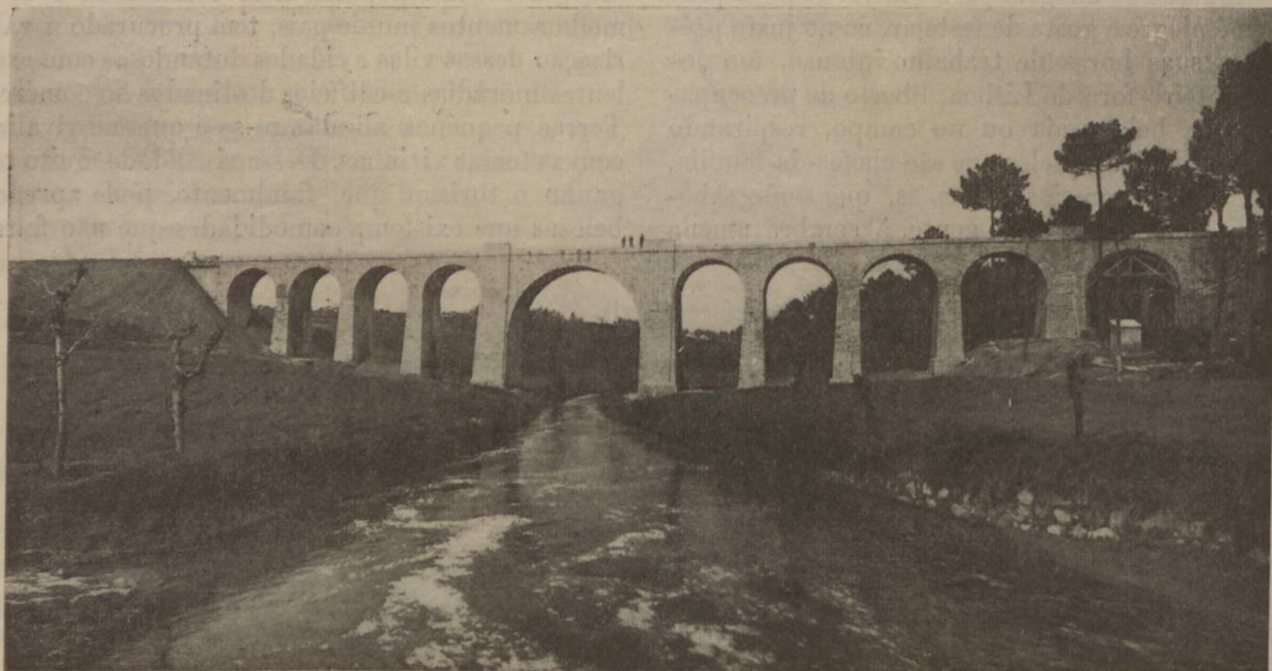
SEIA — Ponte sobre o rio
