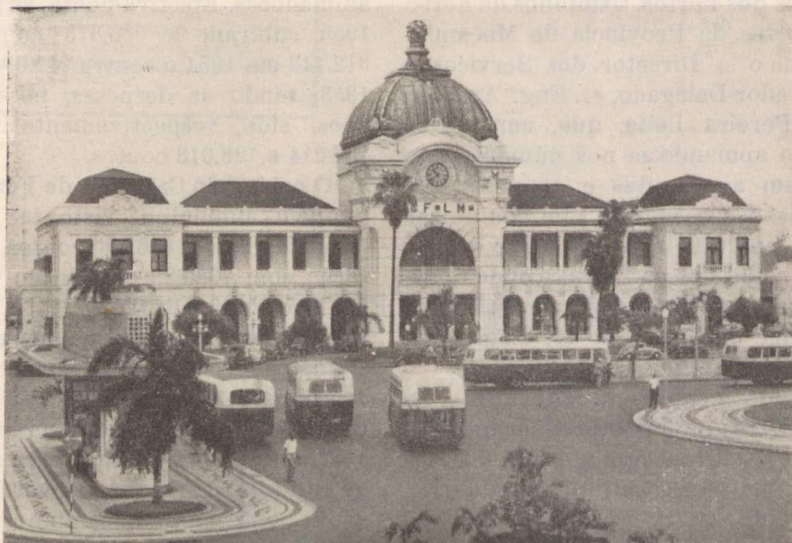
O Edifício da Estação Central de Lourenço Marques
