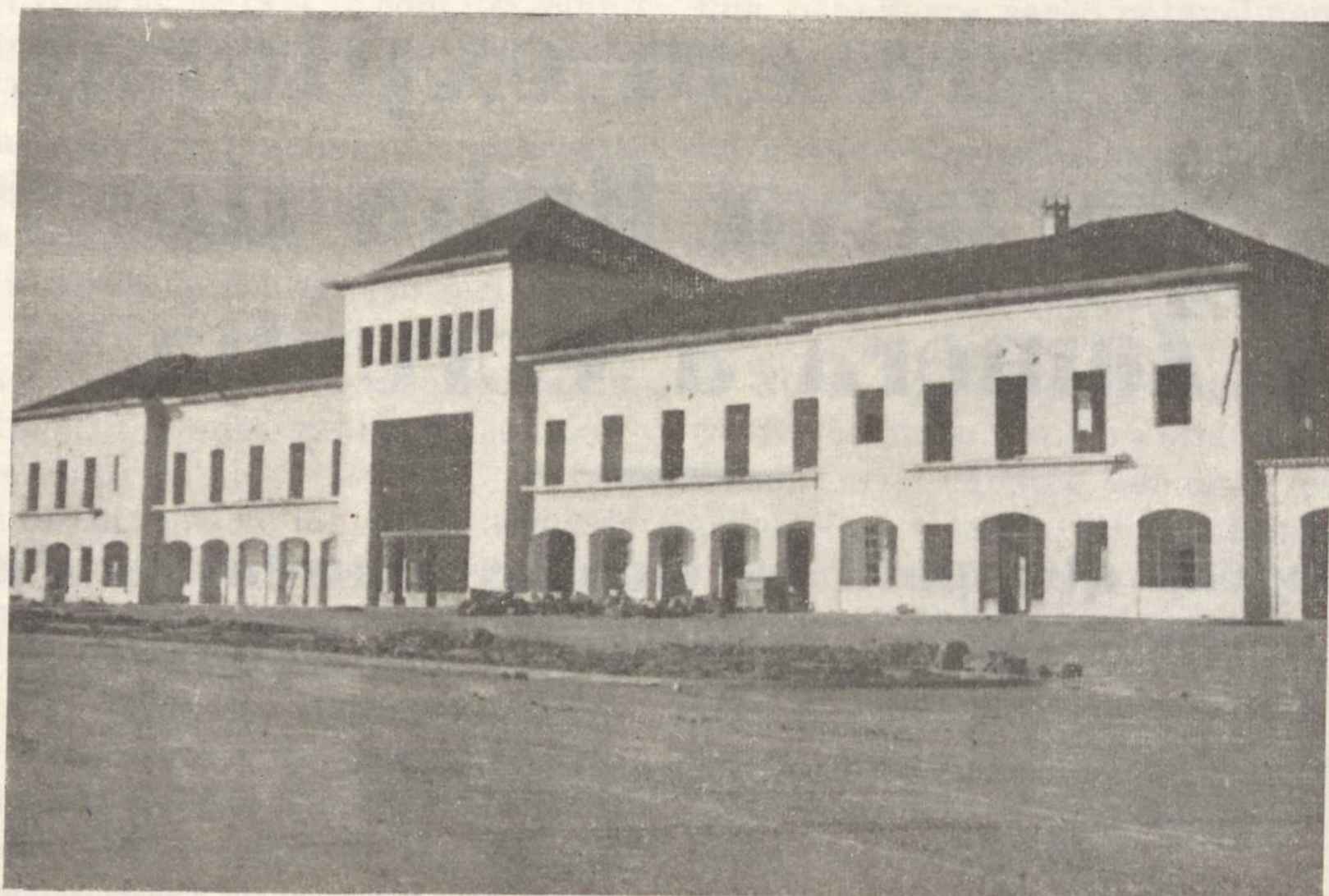
Nova Estação de Orense
