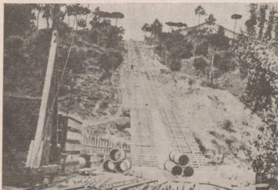
Plano inclinado para subir das ferragens em zorras, duxadas à máquina
