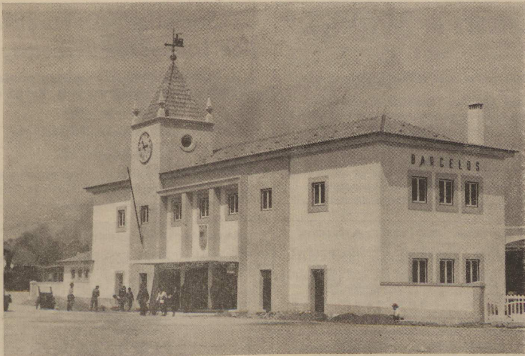
BARCELOS — A entrada da nova estação
