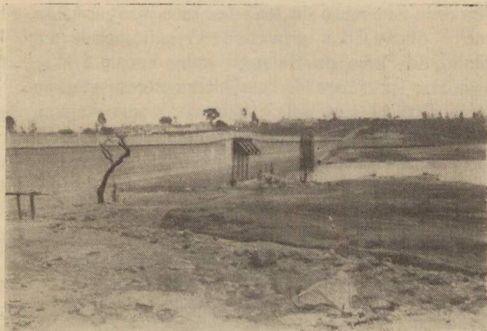
NOVA LISBOA — Barragem no rio Quando (barragem do Caminho de Ferro de Benguela)
