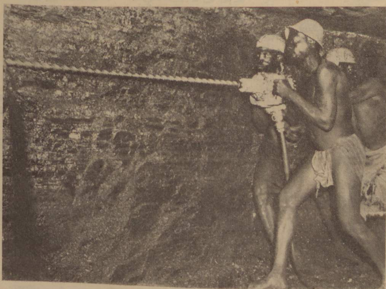
Perfuradora eléctrica em actividade
