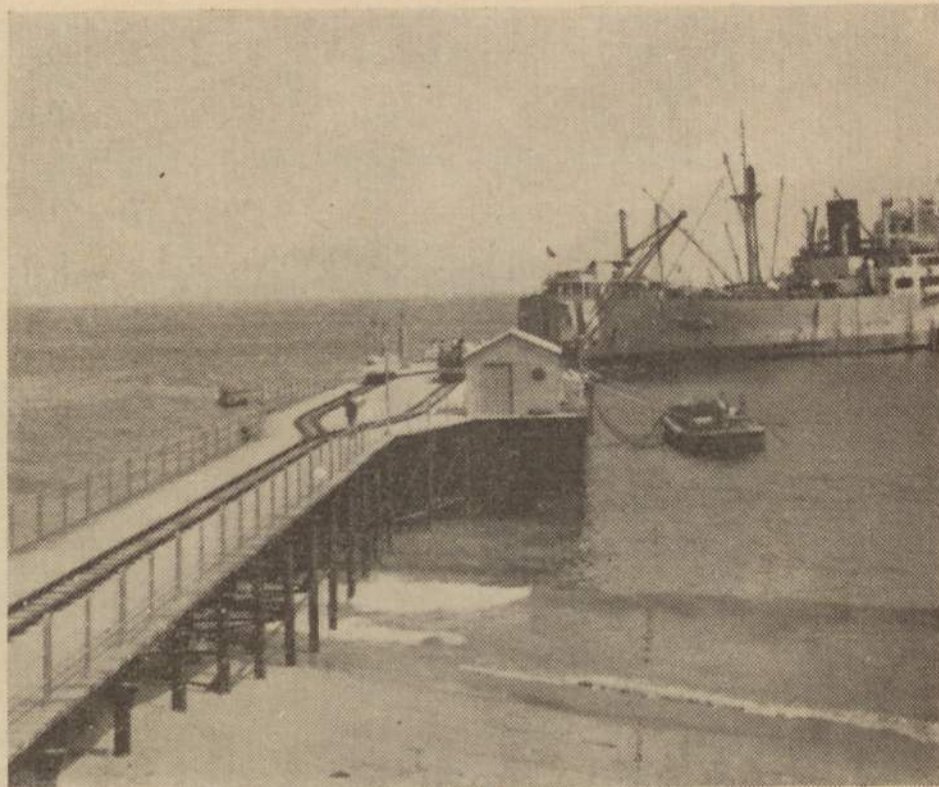
A nova ponte-cais com um vapor à carga
