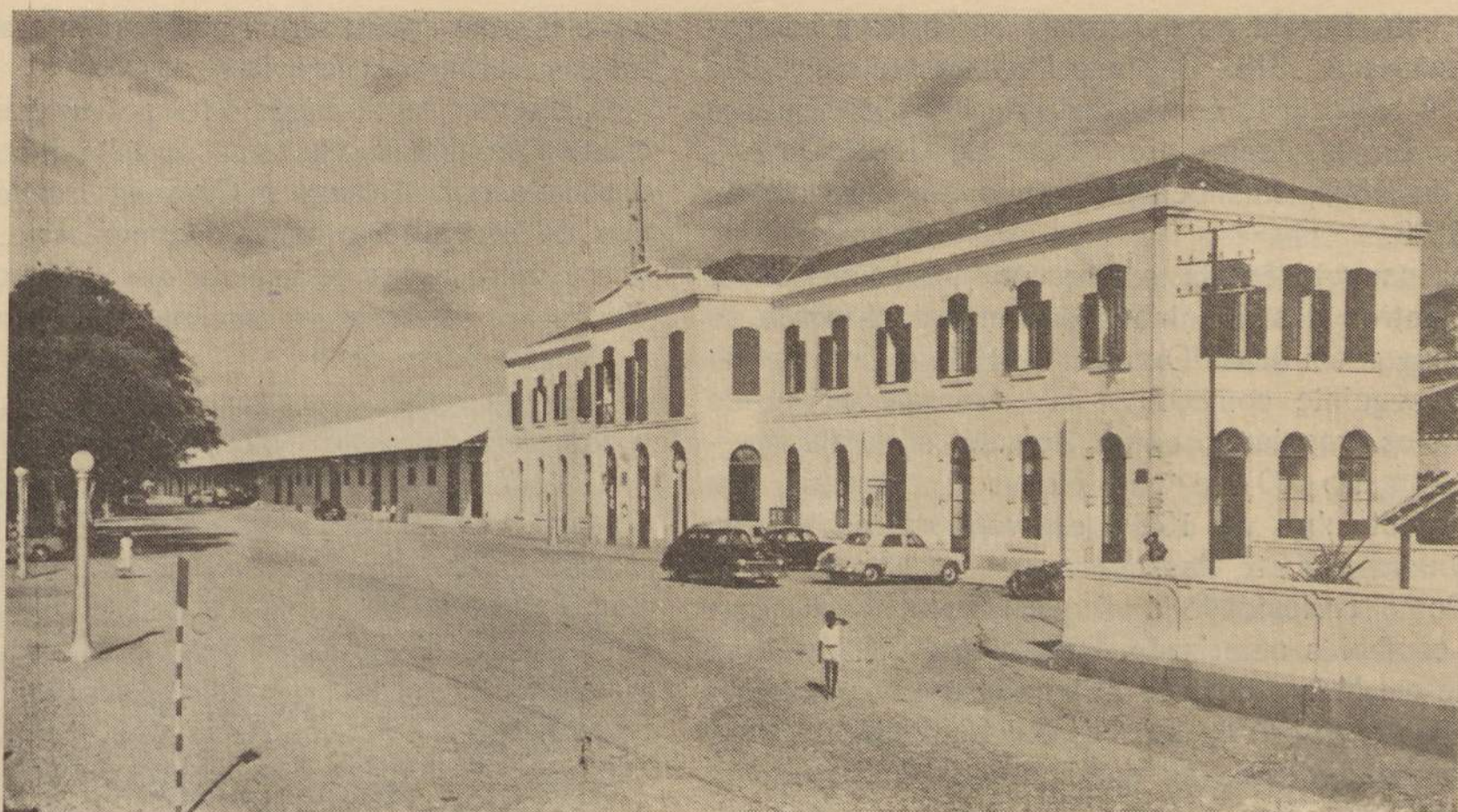
Estação de Luanda da Linha Luanda-Malange (Caminho de Ferro do Estado)
