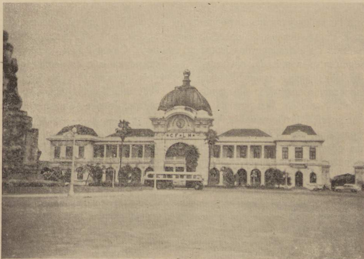
Edifício da Estação do C. Ferro de Lourenço Marques
