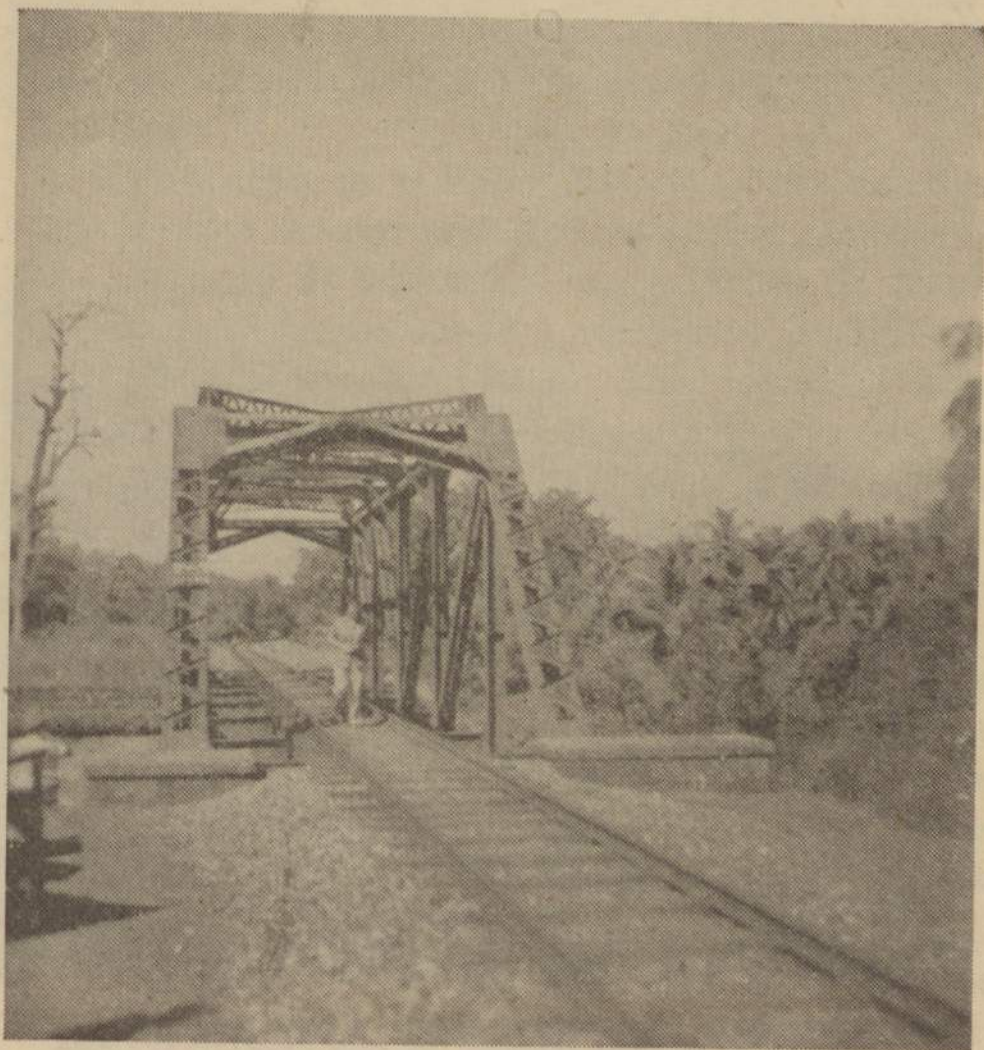
Vista duma ponte metálica de tabuleiro inferior
