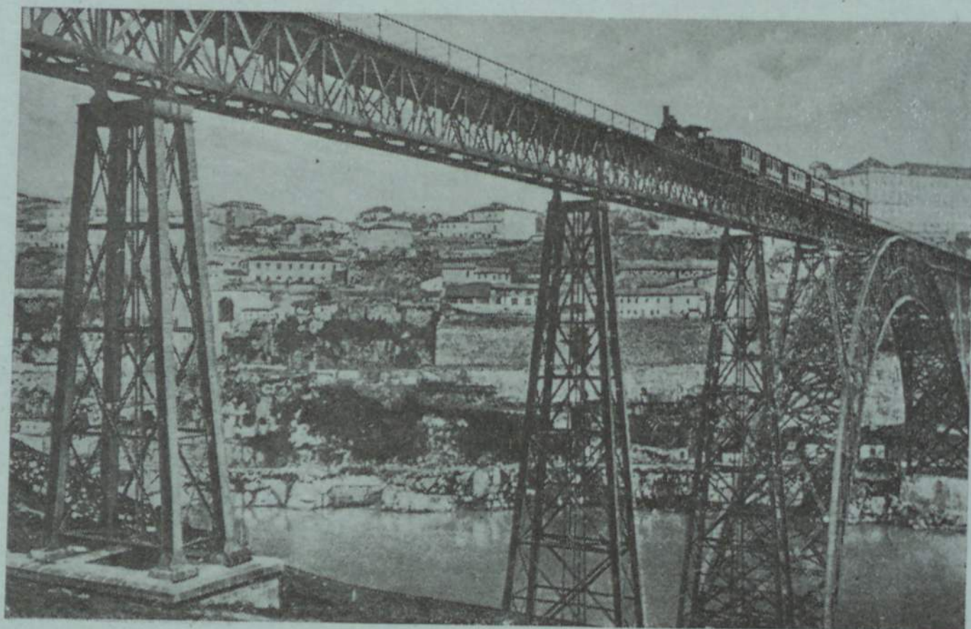
PORTO — A ponte de D. Maria Pia
