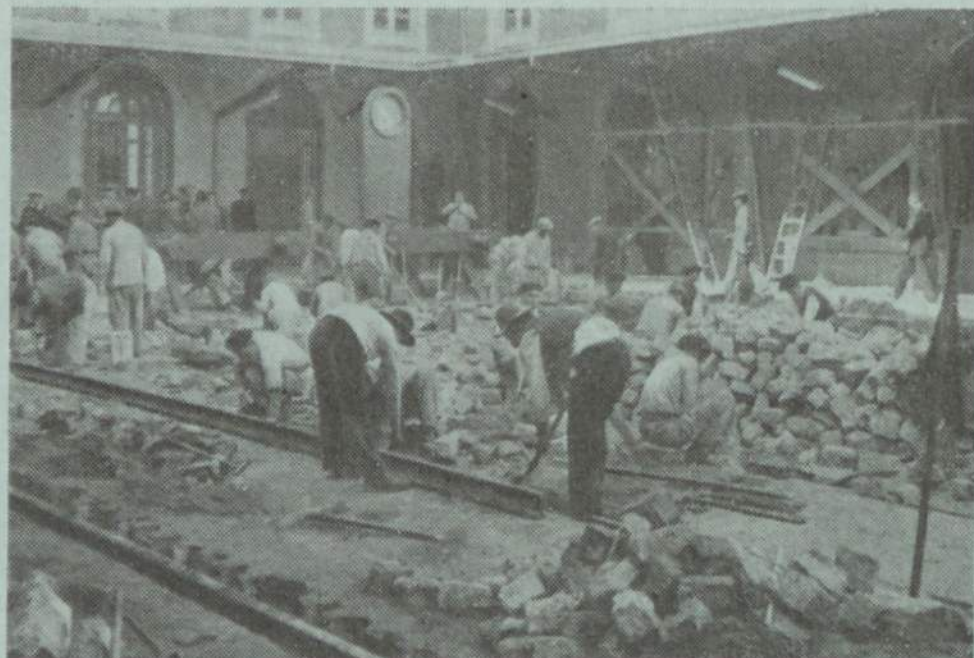
Na estação de Santa Apolónia o chuveiro de operários monta linhas, constrói bilheteiras, retoca paredes, monta autofalantes, e tudo funciona normalmente no dia imediato
