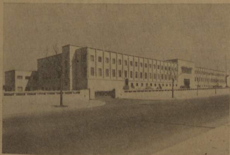
Edifício do Laboratório de Engenharia Civil Construído pela casa ARTUR FERNANDES ALVES RIBEIRO
