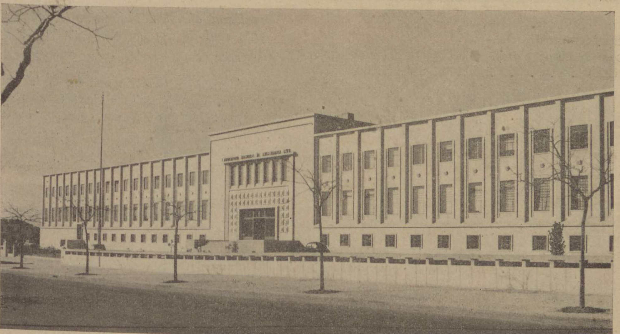
LISBOA — Laboratório Nacional de Engenharia Civil
