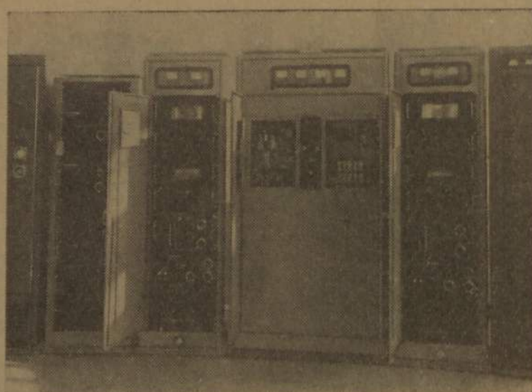
En haut: Emetteur } Shift AME de 2,5 KW Acima: Emissor } En bas: Matériel électrique Em baixo: Material eléctrico
