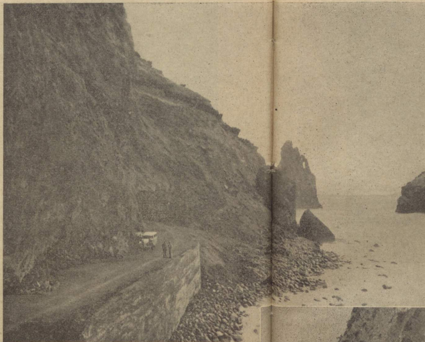
FUNCHAL — Em cima : Trecho da E. N. 1-1.º — Túnel junto à ribeira da Janela
