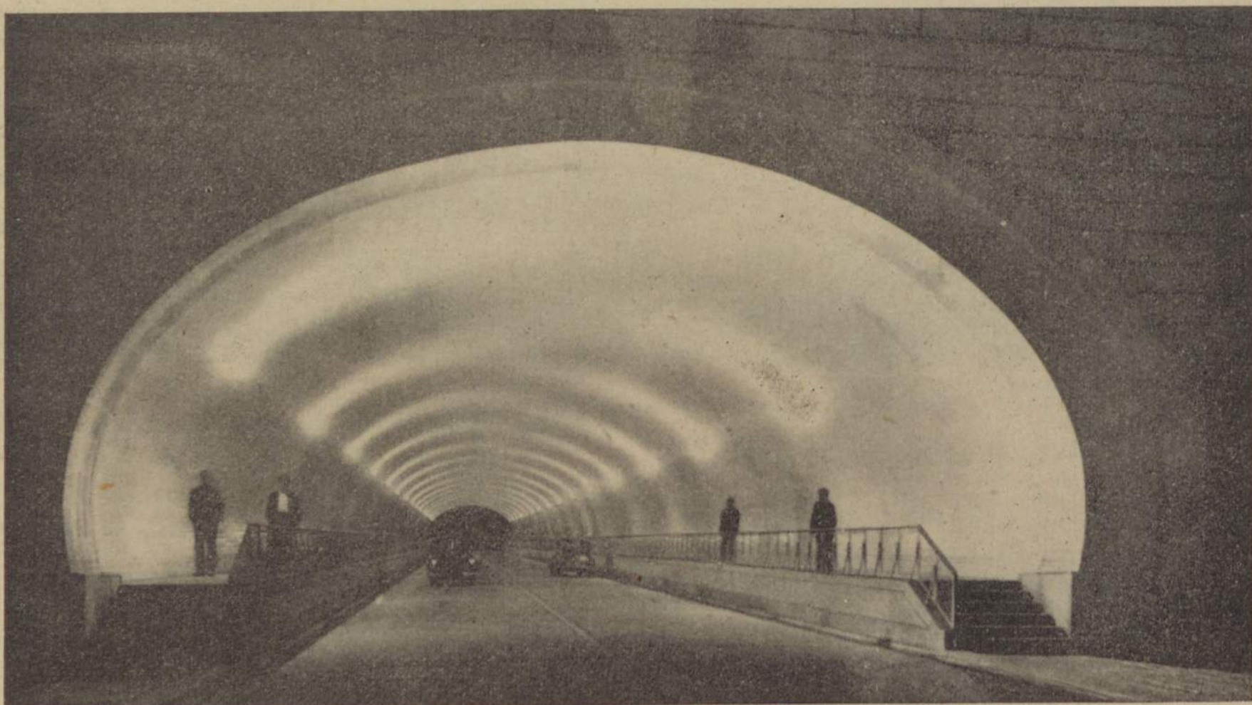
PORTO — Túnel da estrada marginal do Douro
