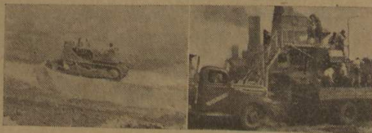
Terraplanagens -- Máquina de betão asfáltico
