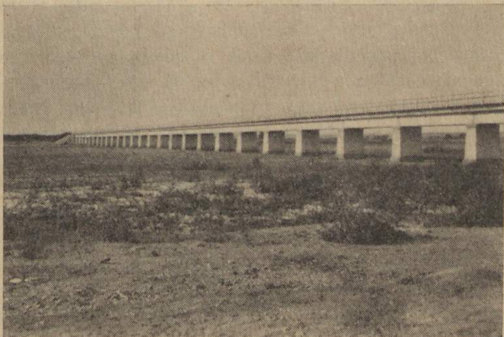
Caminho do Ferro de Moçâmedes — Ponte sobre o rio Bero
