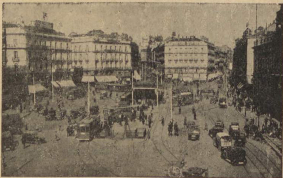
Portas do Sol, antes das recentes obras
