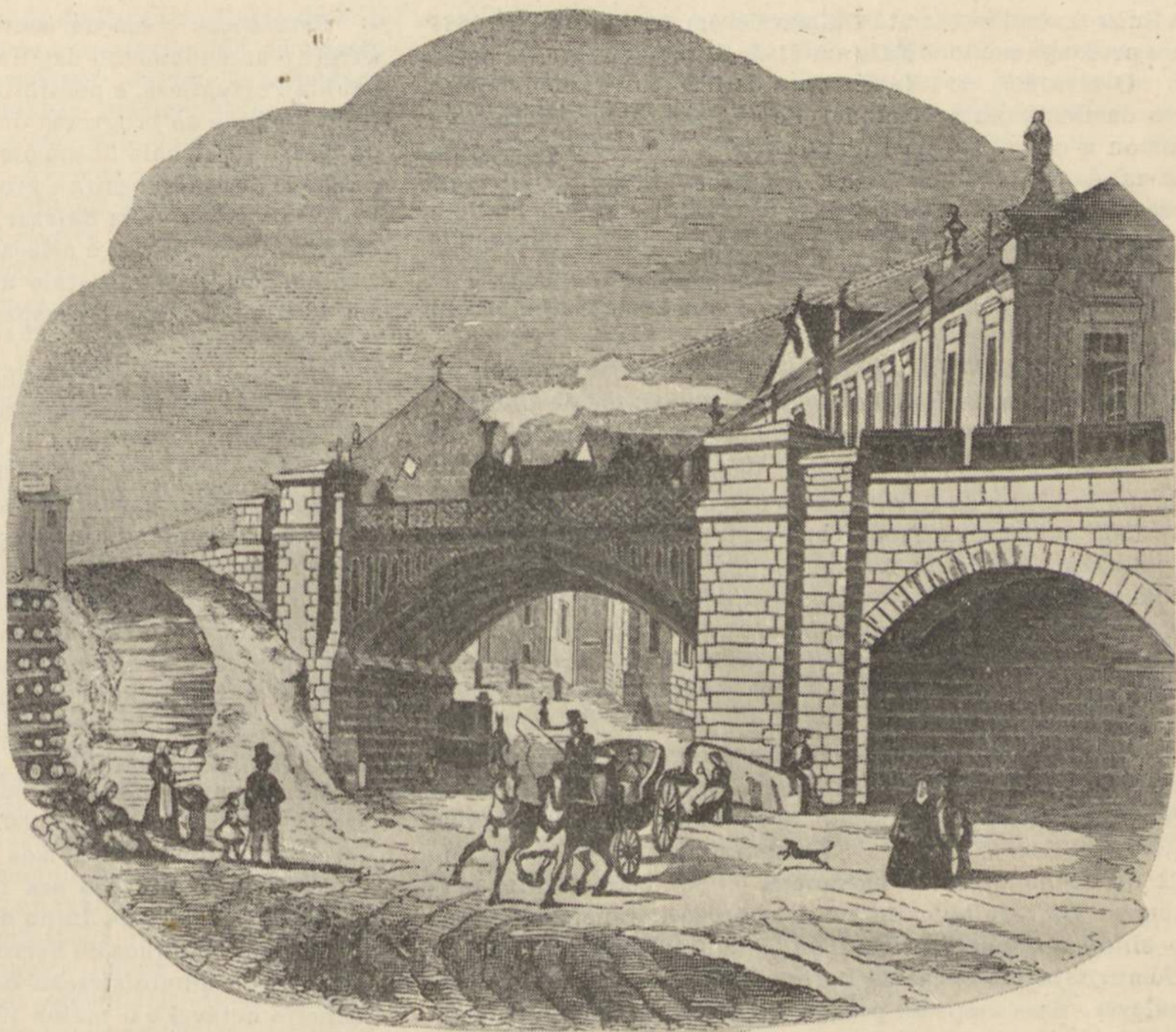
Bordalo Pinheiro dá-nos um desenho que representa a primeira trincheira (de Xabregas) aberta em Setembro de 1857 para a construção da linha Lisboa-Santarém, trabalho executado a um quilómetro da Estação de Santa Apolónia
