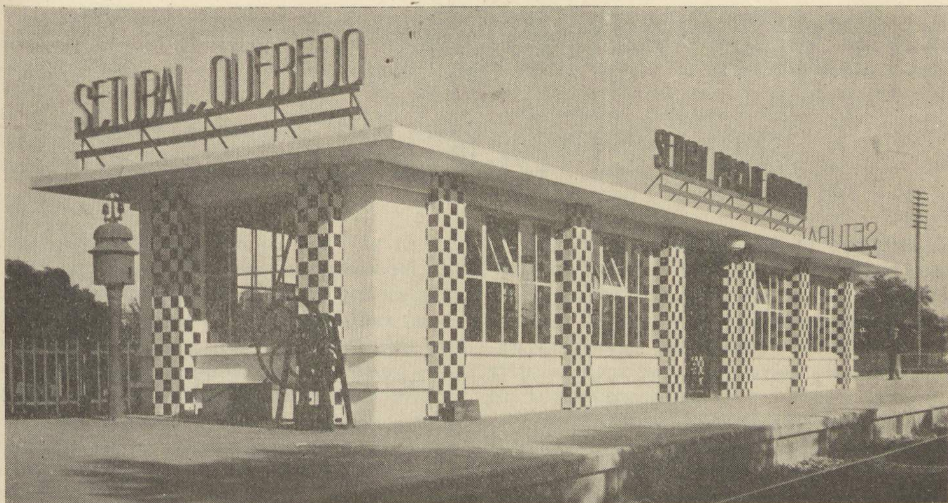
Abri pour voyageurs de la Praça de Quebedo à Setúbal
