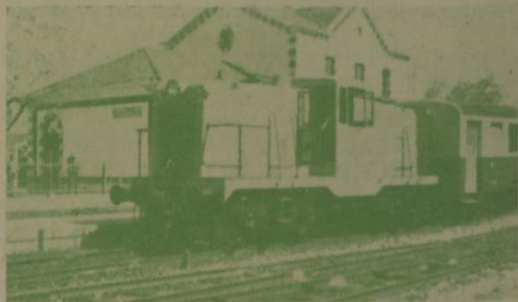
Dois grupos D-17.000 Diesel-Caterpillar de 190 B. H. P. cada, de 8 cilindros em V, montados nas 12 locomotivas de 44 toneladas da General Electric, fornecidas à C. P.
