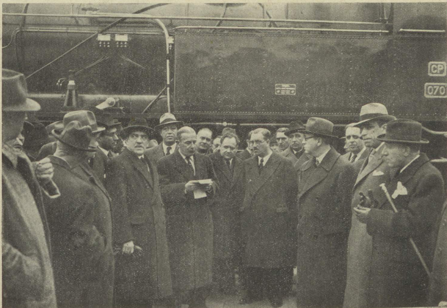
O ilustre engenheiro Pedro de Brion descreve as características da nova máquina e exalta a competência e dedicação dos operários da C. P. que na mesma trabalharam
