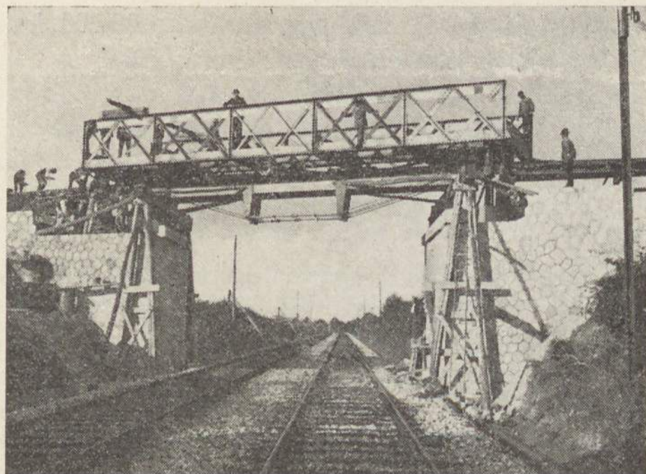
Colocação do viaduto metálico do ramal do Canal de S. Roque, para passagem do Vale do Vouga sobre a C. P.
