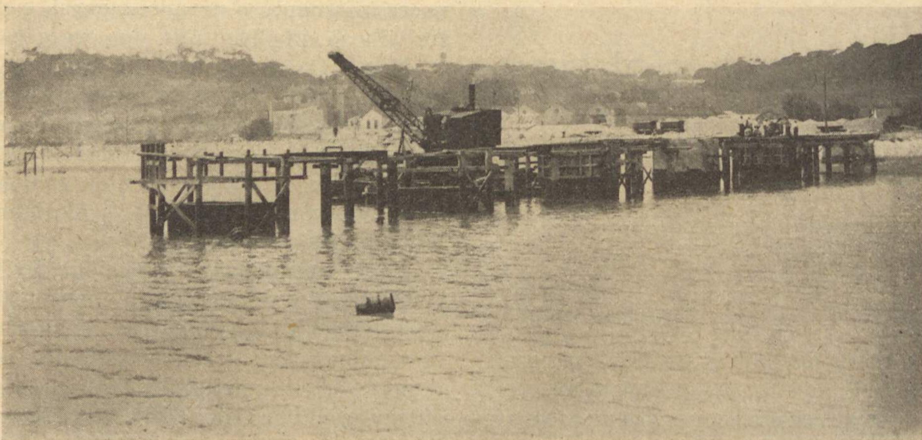
Construção de uma ponte-cais para atracação de submersíveis
