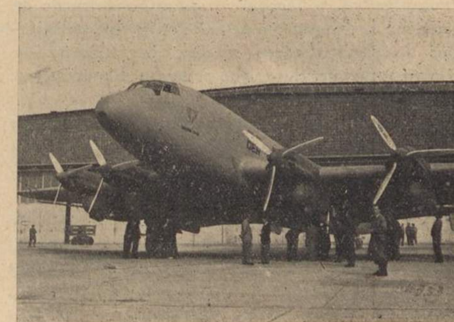
O Ju-90 — o maior avião da frota aérea da Alemanha — 4 motores, 40 lugares — 4000 cavalos
