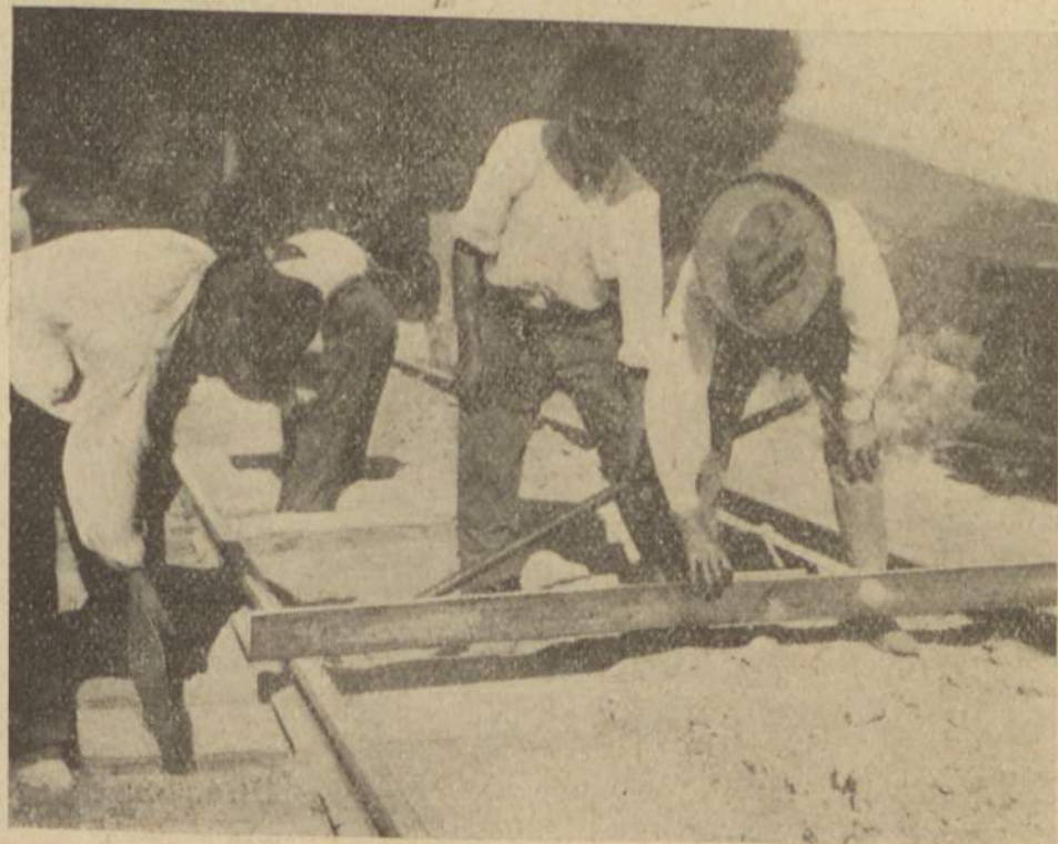
Nivelamento da via em recta
