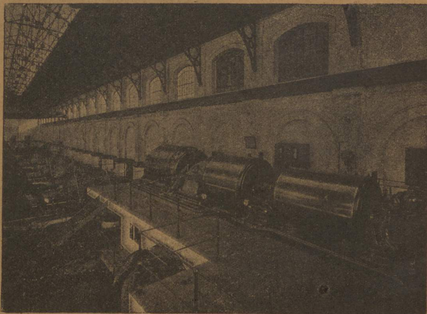
O turbo grupo a vapor de 5.000 kilowatts da Central de Massarelos da Companhia Carris de Ferro do Porto
