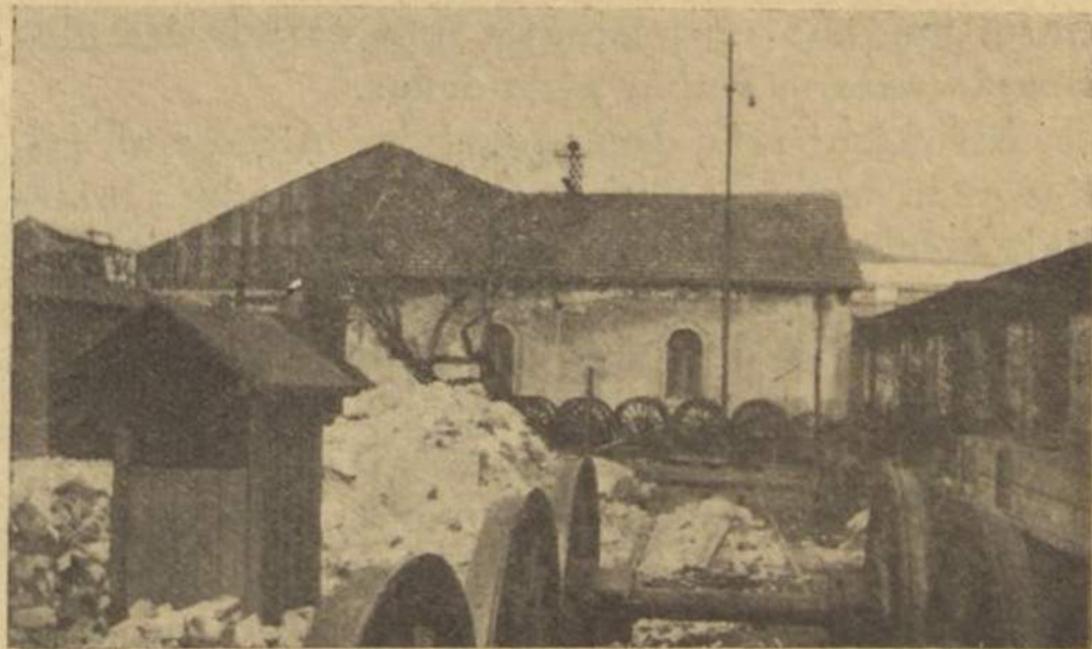
O antigo depósito de moldes e parte do antigo parque de rodados. No fundo e à esquerda vê-se a antiga gare dos C. F. S. S. construída em 1859 onde estiveram instaladas durante longos anos as antigas oficinas de ferraria, montagem, tornos, fundição, caldeiros de cobre e funileiros
