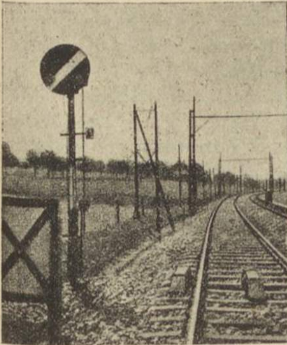
Figura 1—Eléctro-imam da via ao sinal a distância, mostrando o contacto acionado pelo disco de sinalização.
