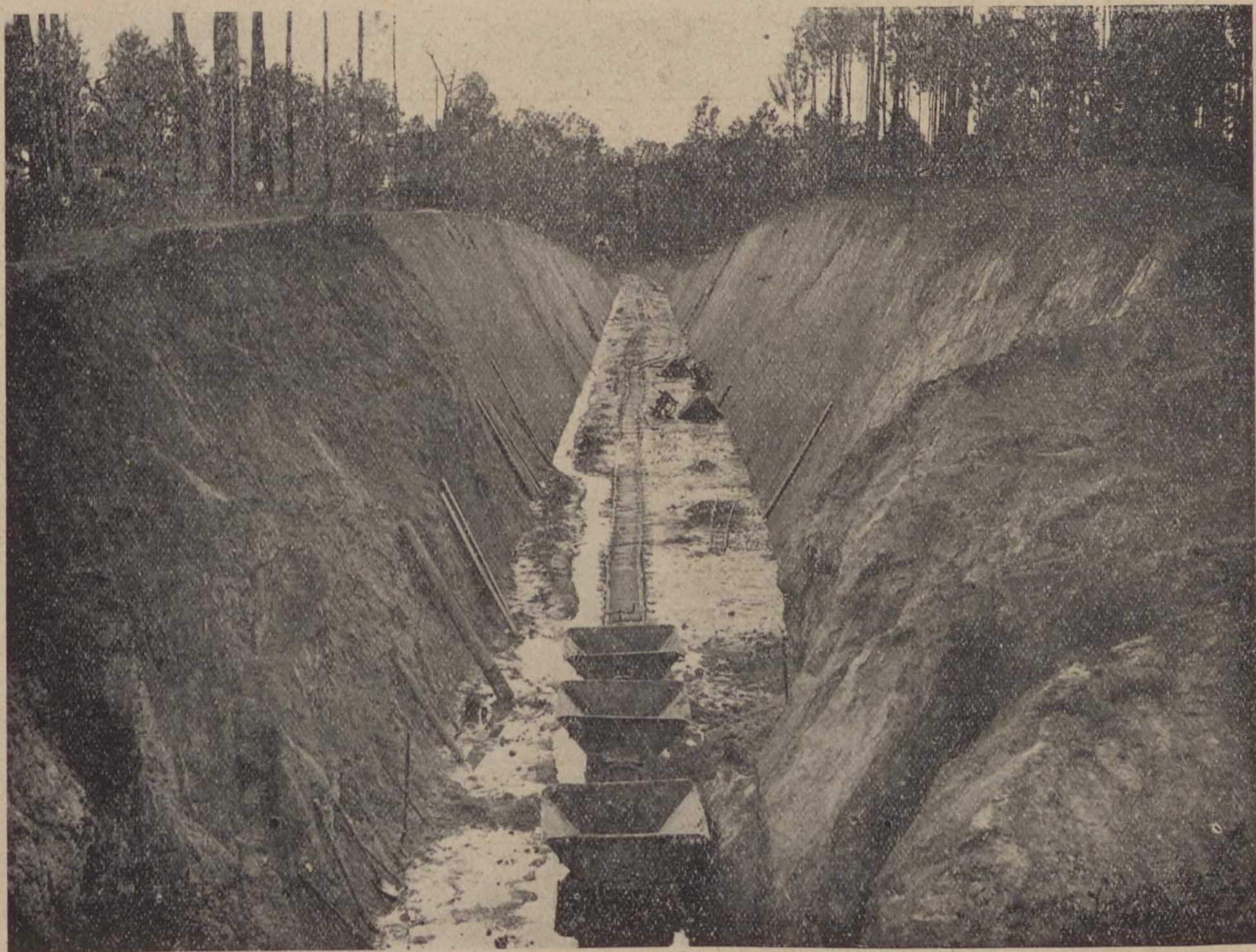
Trincheira da Ribela entre p. p. 121 e 141 do 2.º lanço
