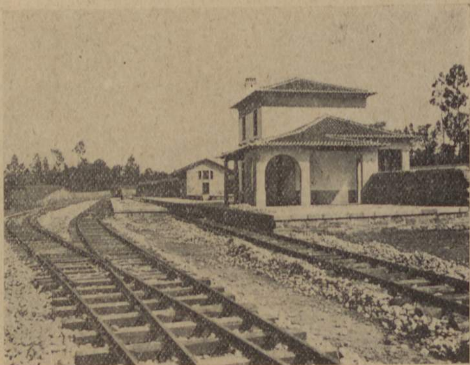
Estação de Barreiros depois do assentamento
