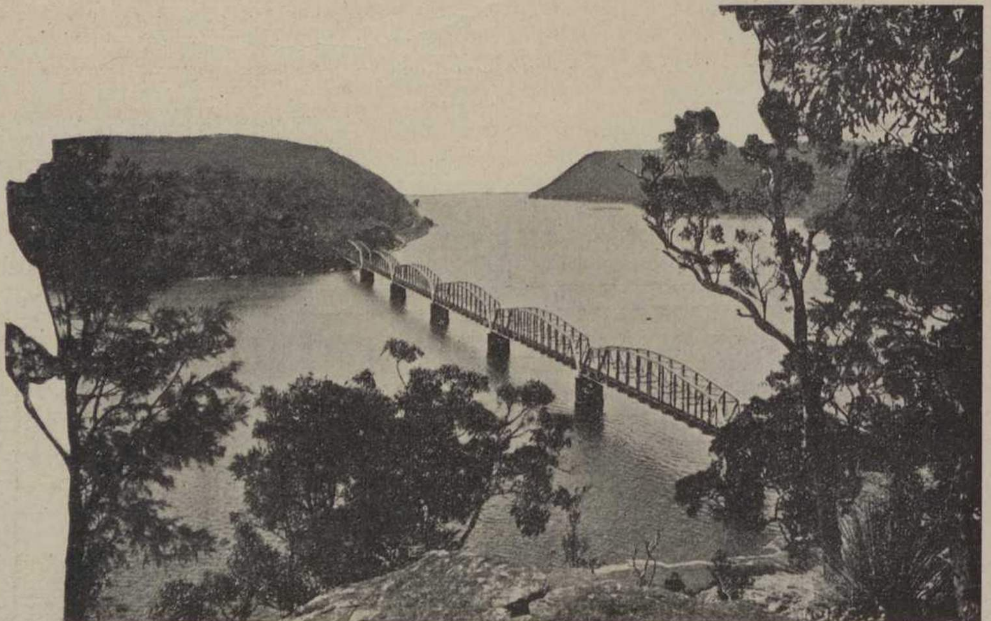
Ponte metálica sôbre o rio Hawkesbury
