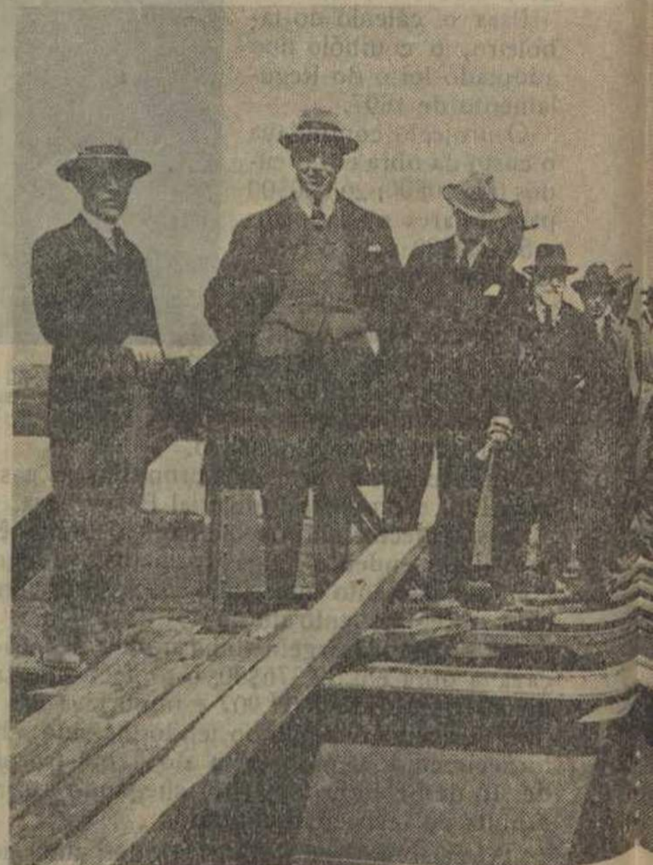
O engenheiro Snr. Plínio e Silva ao inspecionarem a ponte sobre o Solo.
